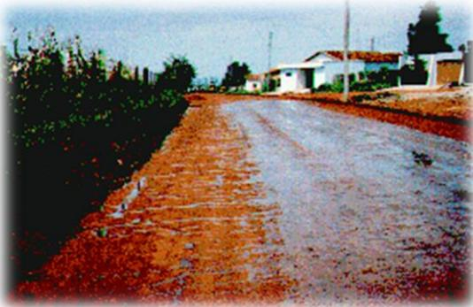
Figura 18 - Execução de solo cimento.
