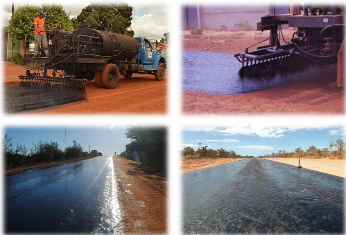
Figura 45 - Execução de imprimação sobre base acabada.
