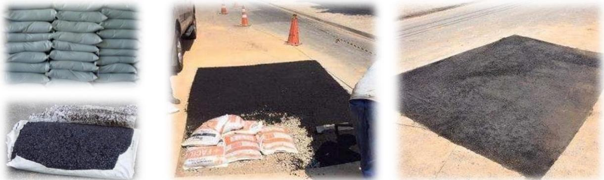
Figura 43 - Execução de serviço de tapa-buraco com pré-misturado a frio.
