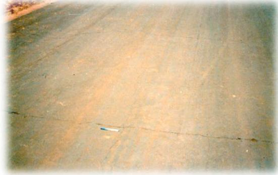
Figura 17 - Camada de solo arenoso fino lateríticos.
