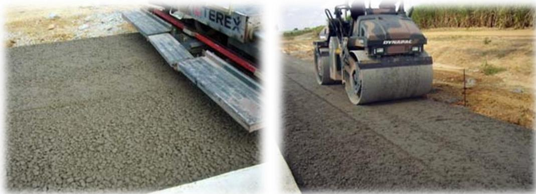
Figura 21 - Execução de camada de base de BGS.
