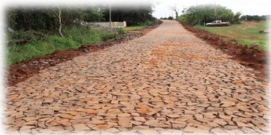
Figura 29 - Rua com alvenaria poliédrica.
