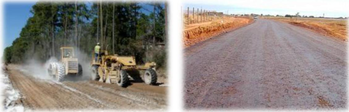
Figura 27 - Execução da camada de solo cal.
