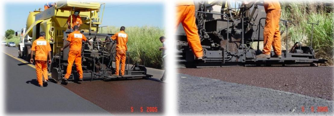
Figura 44 - Execução de camada de microrrevestimento a frio.
