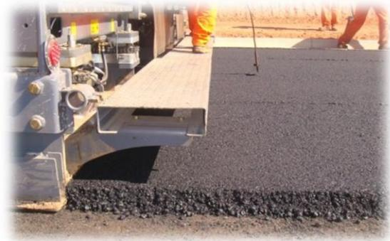
Figura 33 - Execução de concreto asfáltico.
