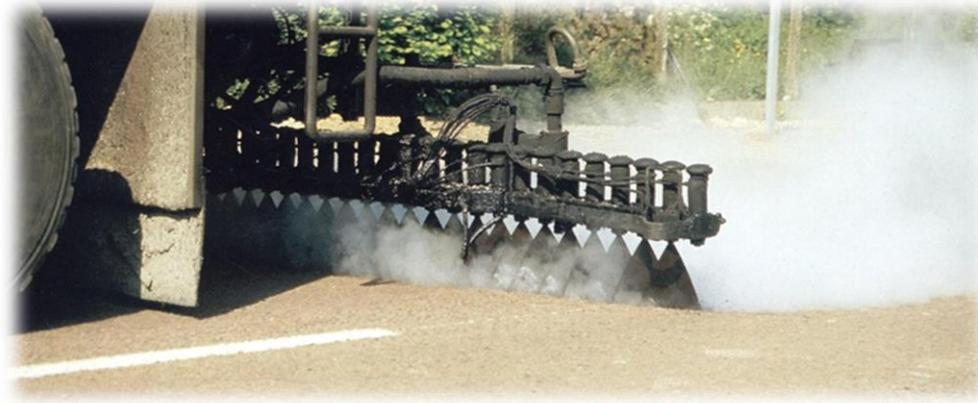
Figura 46 - Execução de pintura de ligação.
