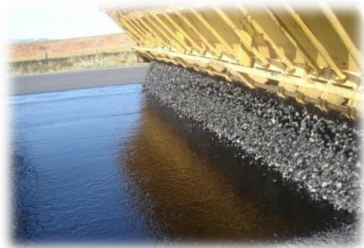
Figura 41 - Lançamento de agregados.
