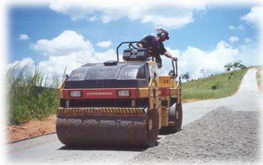
Figura 25 - Compactação da camada de base de BGTC.
