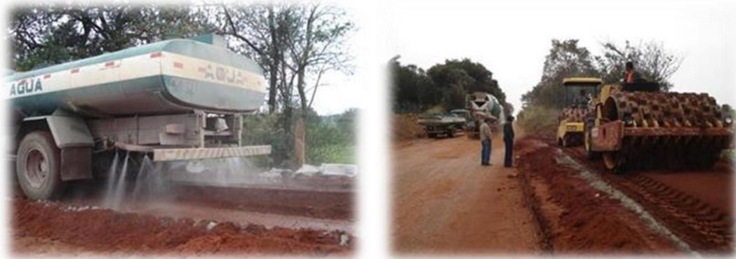
Figura 26 - Execução da camada de solo-cimento na Pista Experimental do Mackenzie.
