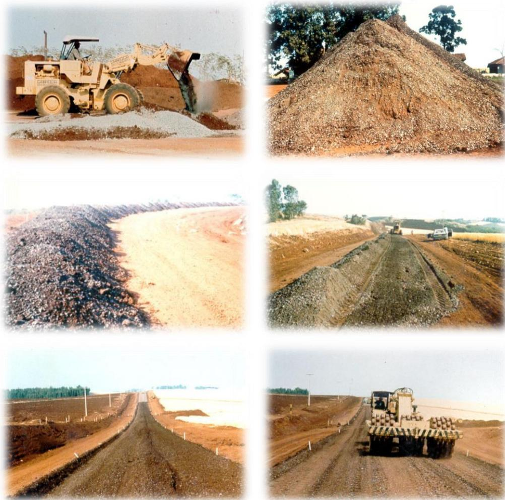
Figura 23 - Execução da camada de solo-brita.
