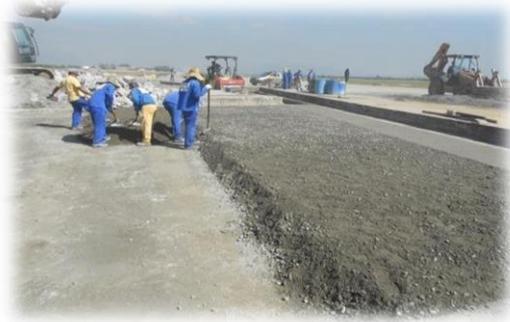
Figura 24 - Lançamento da camada de base de BGTC.
