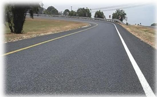
Figura 32 - Revestimento de concreto asfáltico.
