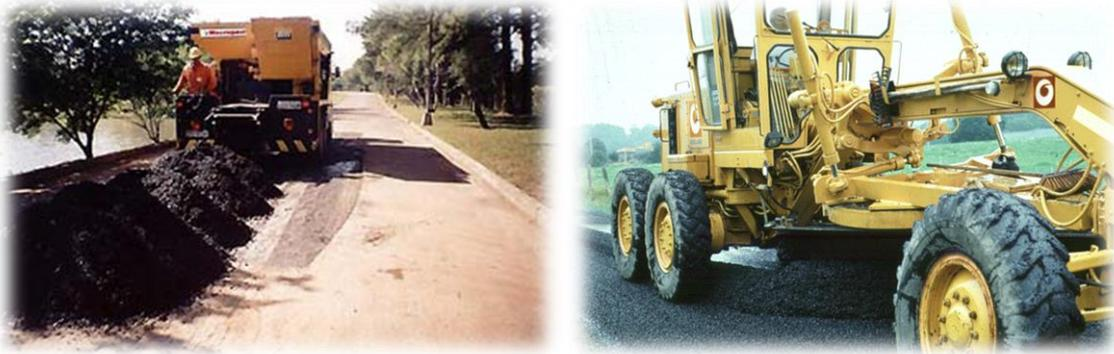
Figura 42 - Execução de camada de revestimento com pré-misturado a frio.
