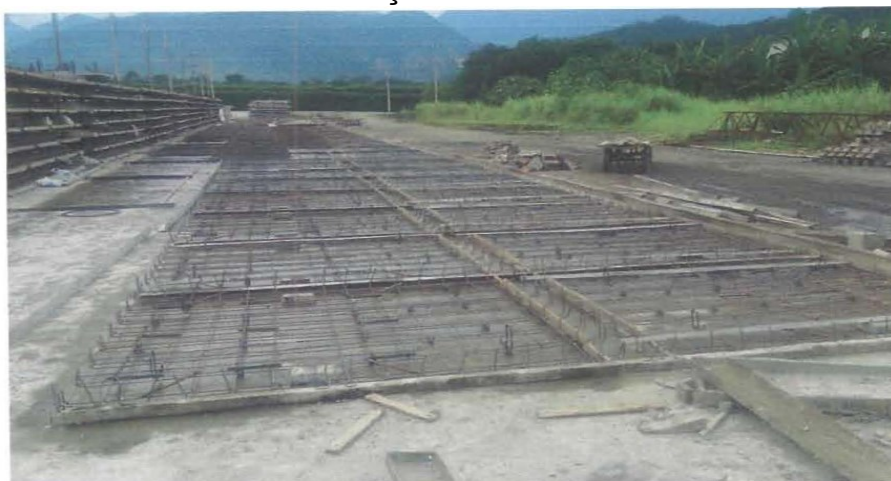
Armadura da pre-laje
